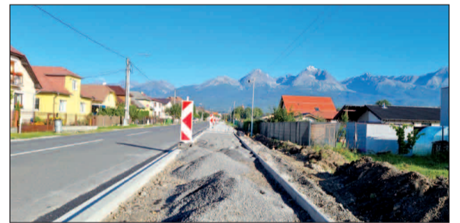
Budovanie chodníka na ul. Osloboditeľov.
