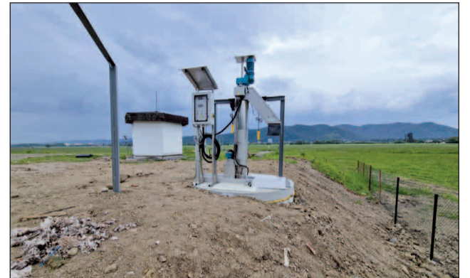
Rekonštrukcia čistiarny odpadových vôd.
